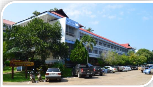
ภาพที่ ๑ อาคารคณะมนุษยศาสตร์และสังคมศาสตร์ (ถ่ายมุมด้านขวาของอาคาร)
