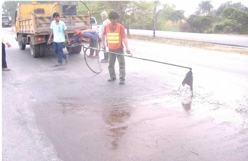
ภาพที่ 42 แสดงการใช้เครื่องสเปรย์อย่างทีพัฒนาขึ้นใช้แรงดันจากท่อไอเสียของรถบรรทุก 6 ล้อ เพื่อการซ่อมบำรุง (1)
