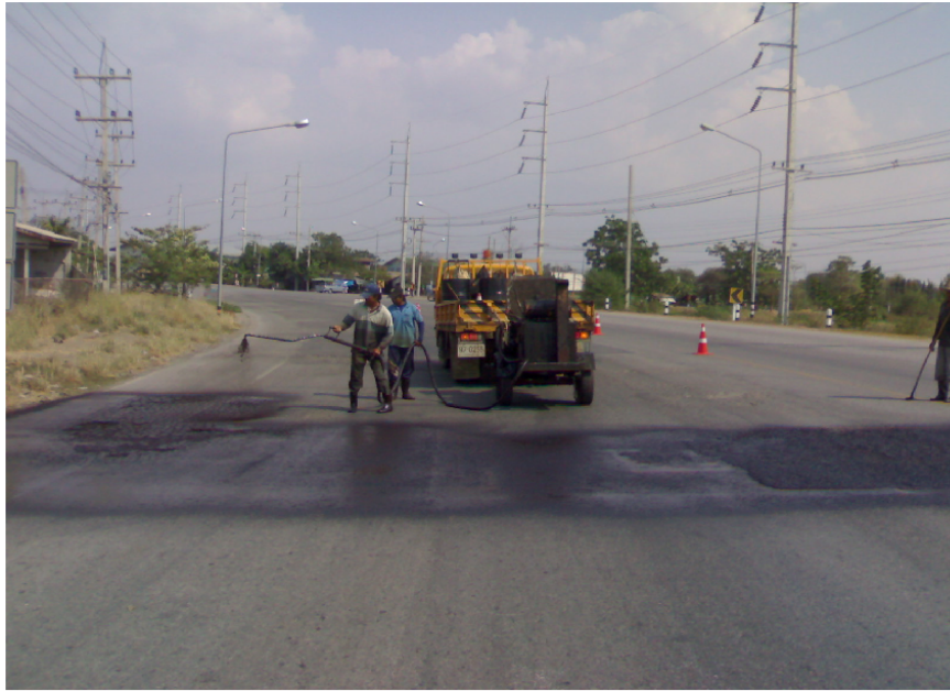
ภาพที่ 40 แสดงการใช้เครื่องสเปรย์ยางแอสฟัลท์คั่นแบบเพื่อการซ่อมบำรุง
