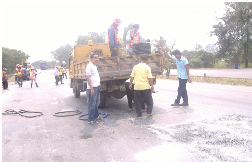
ภาพที่ 43 แสดงการใช้เครื่องสเปรย์อย่างทีพัฒนาขึ้นใช้แรงดันจากท่อไอเสียของรถบรรทุก 6 ล้อ เพื่อการซ่อมบำรุง (2)
