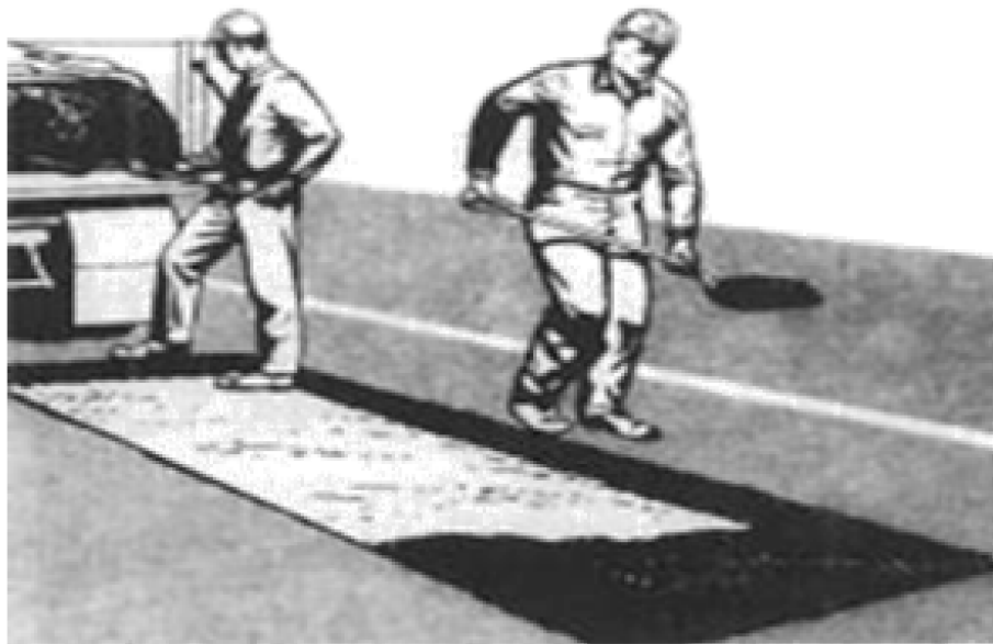
ภาพที่ 16 แสดงการตักวัสดุ Premix จากกองที่เทจากรถลงหลุม ที่มา : (กรมทางหลวง, 2549, หน้า 14)
