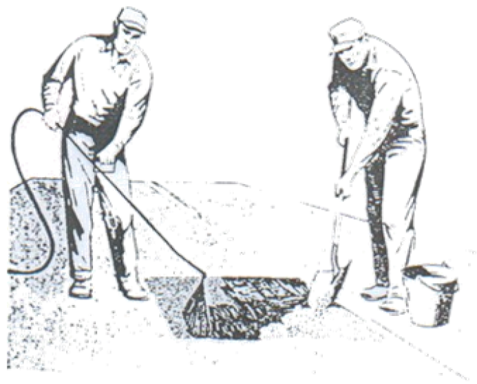
ภาพที่ 13 แสดงการโรยหินเกล็ดลงบนบริเวณที่พ่นยางไว้ ที่มา : (กรมทางหลวง, 2549, หน้า 9)
