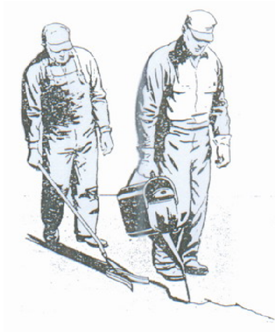
ภาพที่ 21 แสดงการอุดรอยแตกโดยใช้กาหลอด ที่มา : (กรมทางหลวง, 2549, หน้า 18)
