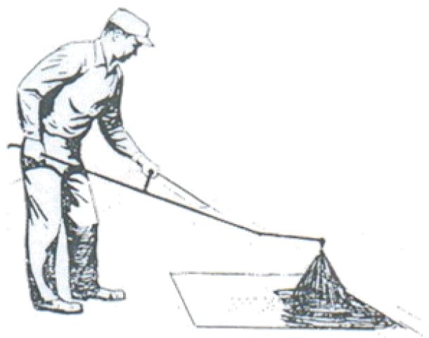
ภาพที่ 12 แสดงรูปการพ่นยางแอสฟัลต์ ลงบนบริเวณที่ทำเครื่องหมายไว้ด้วย เครื่องพ่นยาง
