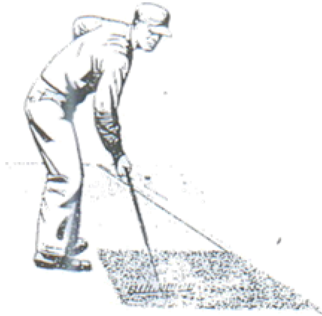
ภาพที่ 26 แสดงการปูวัสดุ Premix ลงไปในบริเวณที่ทำ Tack Coat ที่มา : (กรมทางหลวง, 2549, หน้า 22)
