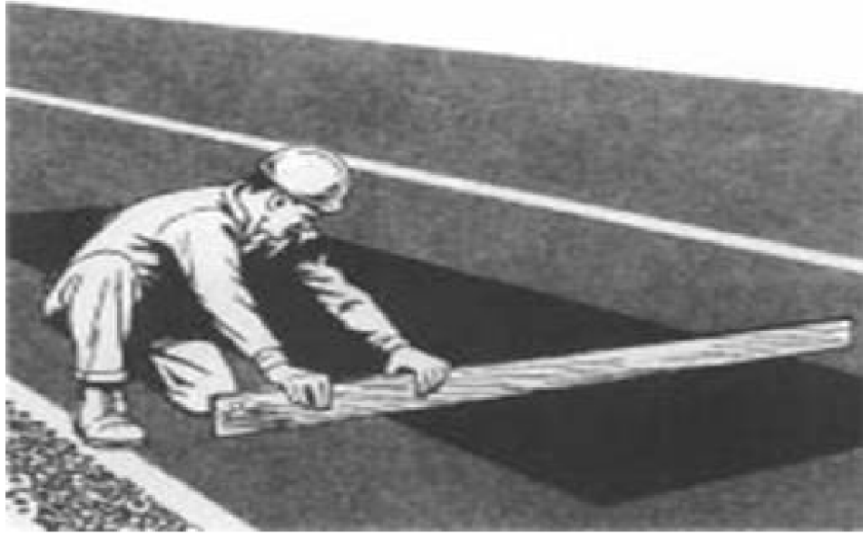
ภาพที่ 19 แสดงการใช้ไม้บรรทัดวัดความเรียบของพื้นช่วยการปรับระดับผิวหน้าให้เรียบ ที่มา : (กรมทางหลวง, 2549, หน้า 15)
