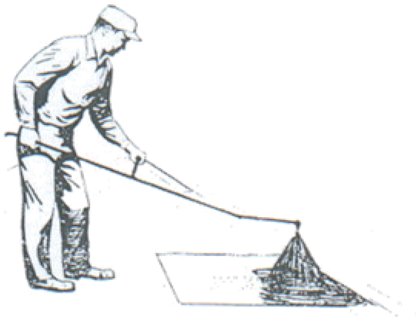
ภาพที่ 25 แสดงการทำ Tack Coat ด้วยการพ่นยางแอสฟัลต์ชั้นบางๆ ที่มา : (กรมทางหลวง, 2549, หน้า 22)
