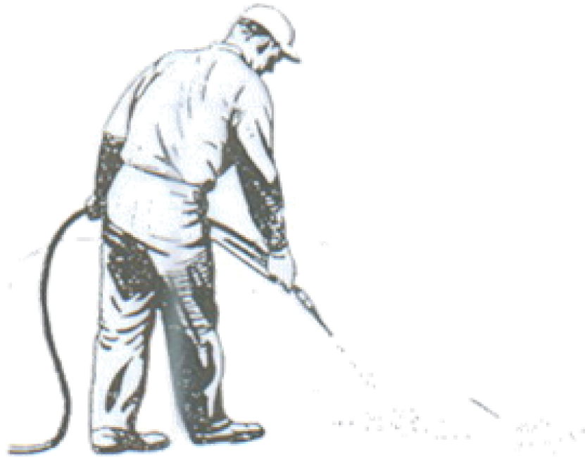
ภาพที่ 24 แสดงการทำความสะอาดบริเวณที่จะซ่อมบำรุงให้สะอาดและแห้งด้วยเครื่องอัดลม ที่มา : (กรมทางหลวง, 2549, หน้า 21)
