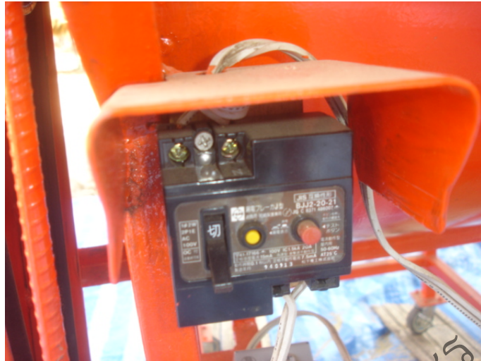
ภาพที่ 29 แสดงภาพการติดตั้งระบบสายไฟฟ้า สวิตช์อัตโนมัติ เบรกเกอร์ เซอร์กิต
