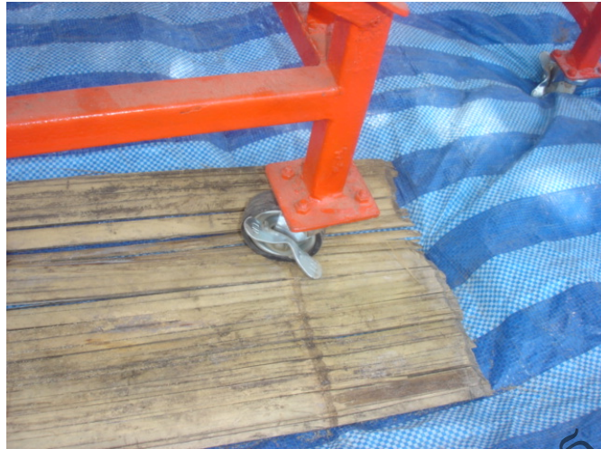
ภาพที่ 31 แสดงภาพการติดตั้งล้อเลื่อน
