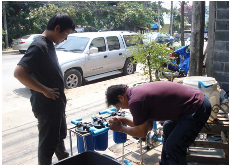
ภาพที่ 28 แสดงการต่อท่อพีวีซีกับอุปกรณ์ของถังกรองหยาบเพื่อเป็นทางเดินของน้ำปลา
