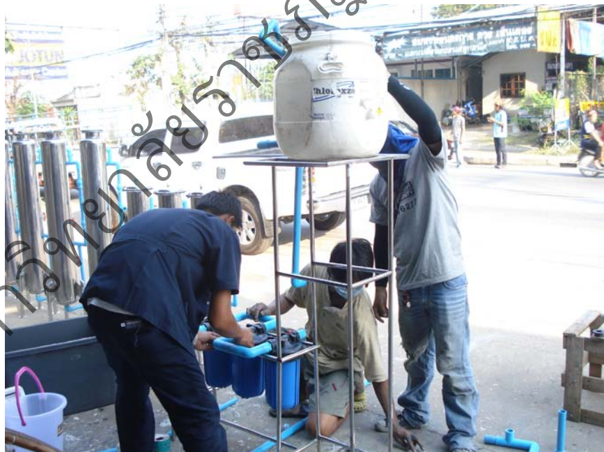
ภาพที่ 31 แสดงการติดตั้งถังสำหรับใส่น้ำปลาที่จะกรองต่อท่อไปยังเครื่องกรอง
