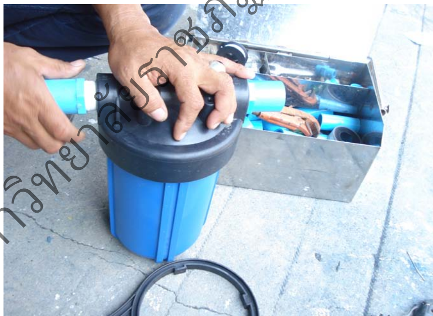
ภาพที่ 27 แสดงการประกอบอุปกรณ์ของถังกรองหยาบ(big blue) เข้าด้วยกันจำนวน 3 ถัง
