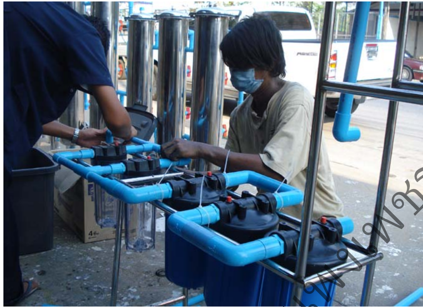
ภาพที่ 30 แสดงการนำถังกรองทั้ง 5 ถังมาเชื่อมต่อเข้าด้วยกัน
