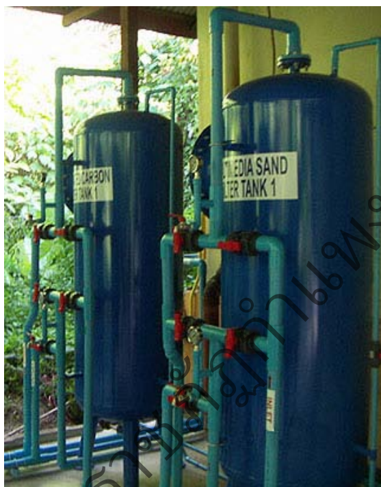
ภาพที่ 12 แสดงลักษณะเครื่องกรองน้ำขนาดใหญ่ ที่มา : (เครื่องกรองน้ำ, 2553)
