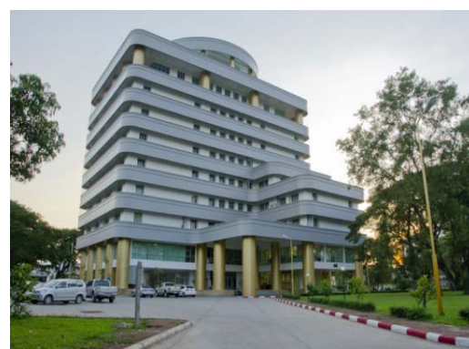
ภาพที่ ๕ อาคารสำนักงานอิถิการบติ ปี พ.ศ. ๒๕๕๕
