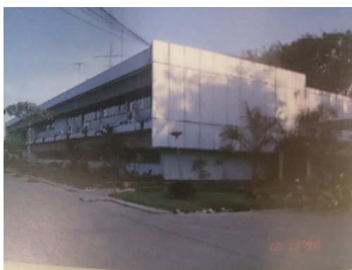
ภาพที่ ๔ อาคารสำนักงานอิถิการบติ ปี พ.ศ. ๒๕๒๑
