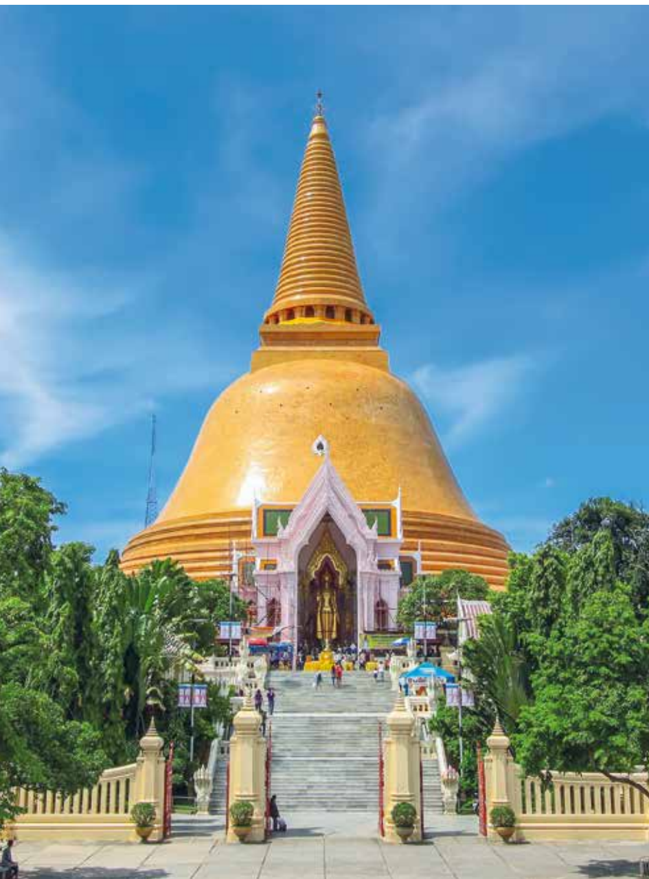
พระปฐมเจดีย์ จังหวัดนครปฐม
